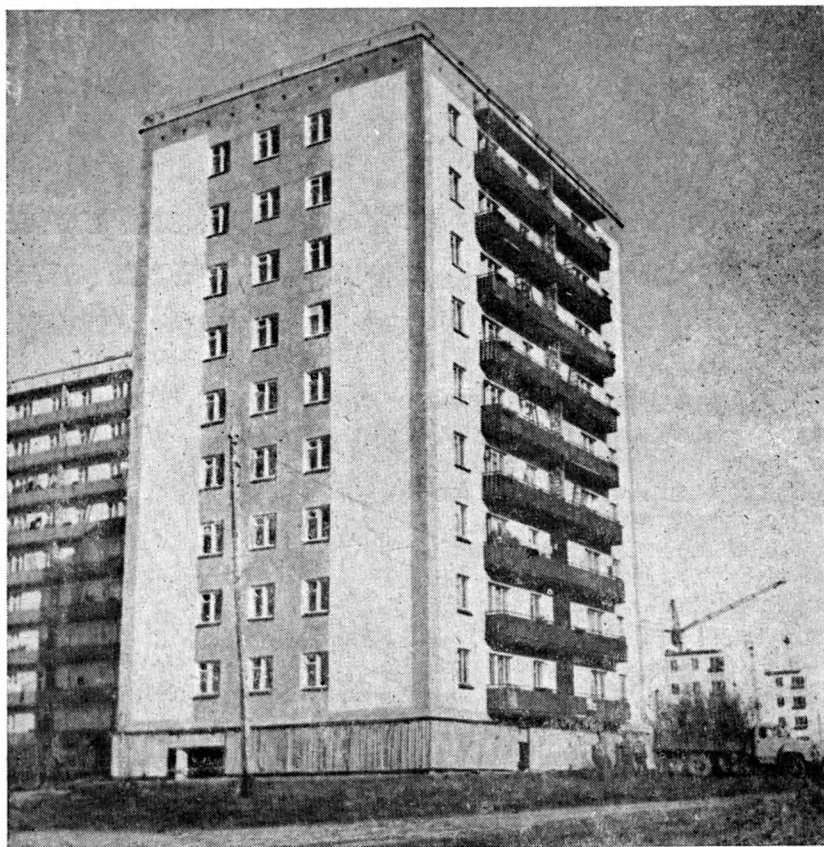
Такие многоэтажные здания построены в городе Мирном Якутской АССР. Они стоят на фундаменте новой конструкции (железобетонные сваи с встроенными охлаждающими устройствами)
