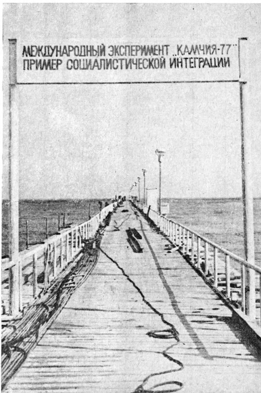
Эстакада в устье реки Камчия на черноморском побережье Болгарии. Здесь изучаются литодинамические процессы
